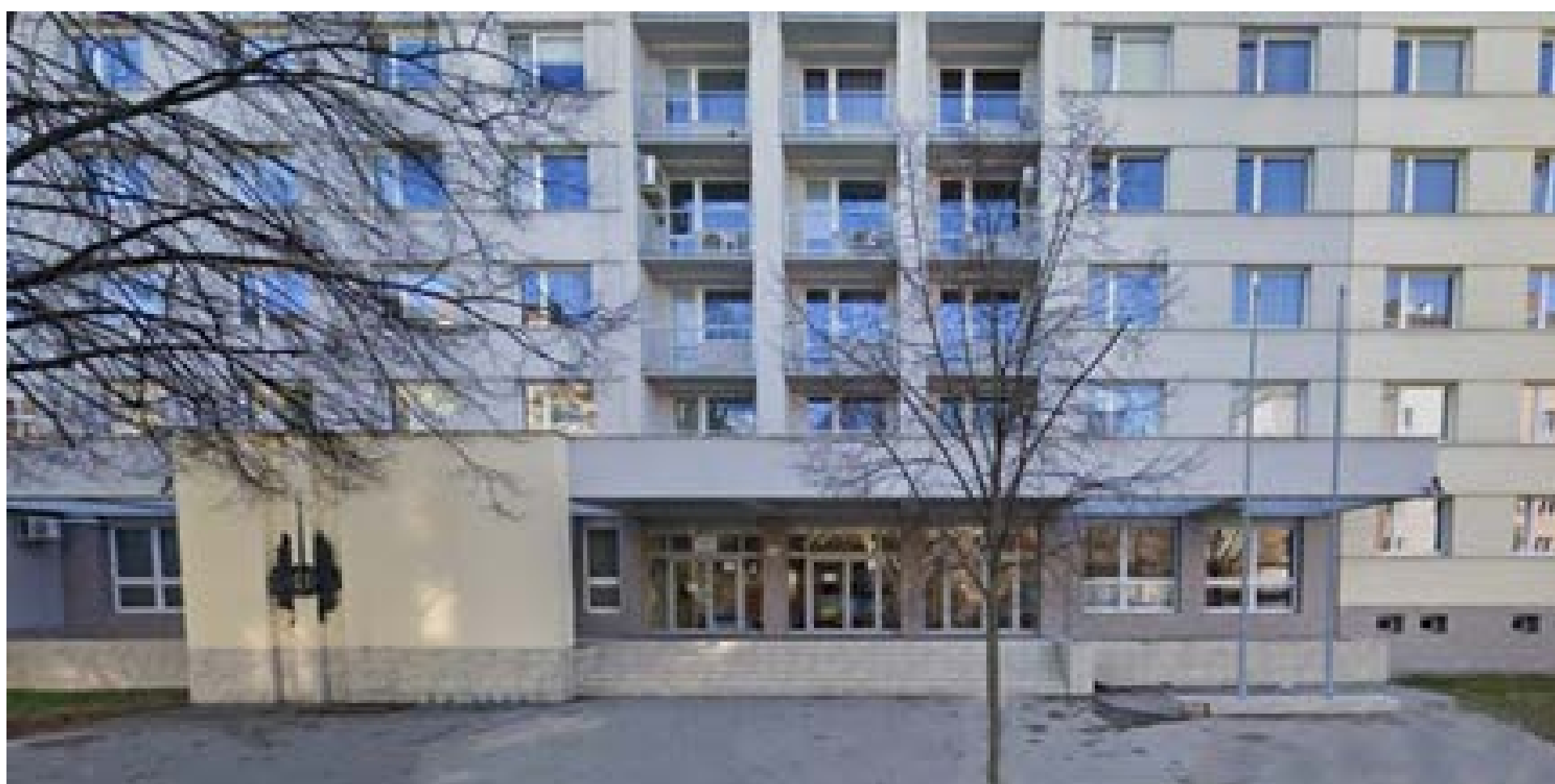
Hlavní vchod do budovy internátu Tučkova 23.
